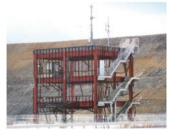
県が2031年まで管理することになった南三陸町防災対策庁舎。かさ上げ工事が進む町は様変わりしています。
