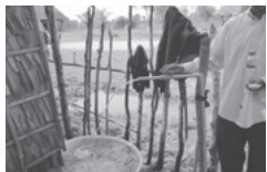
©日本ユニセフ協会 地域で管理している送水管
