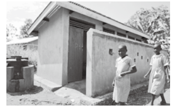
©UNICEF/UGDA2010-00313/ Shehzad Noorani 小学校に建てられたトイレ
