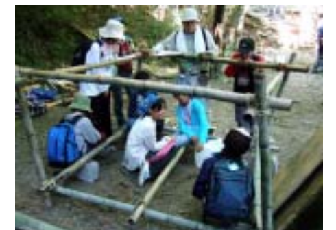
道具を収納するため、倉庫をつくる。
