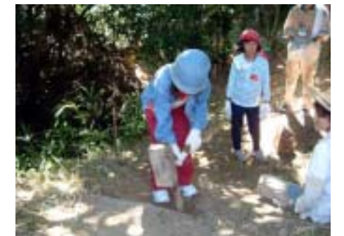
階段をつくるため、杭を木槌で打つ。
