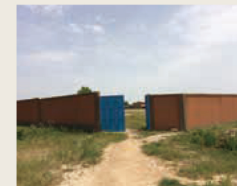
日本の皆さまからのご支援で、学校の外壁が整備されました。外部からの侵入を防ぐ対策のひとつです。
