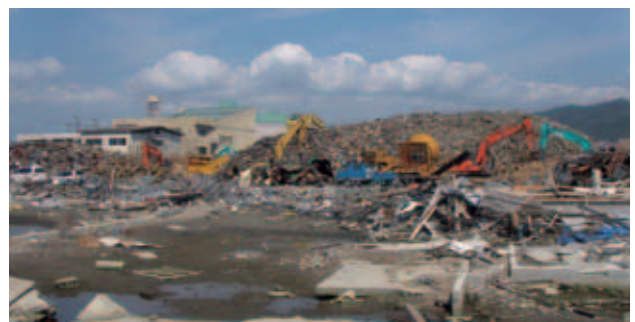
被災後の写真(写真提供:気仙沼市)
