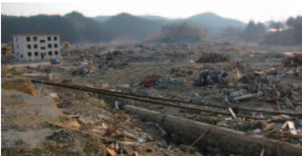
震災から約1ヵ月後(2011年4月15日)、志津川駅方面より撮影された、あさひ幼稚園園舎の被災状況(写真提供:あさひ幼稚園)
