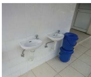
完成した手洗い場（一部）
